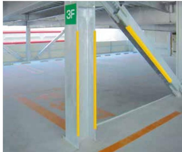
むき出した危険なH鋼の端部をソフトにカバーして、
