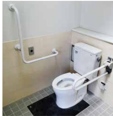
跳上式(FSRT-700)・L型(FSRL 特注寸法)
